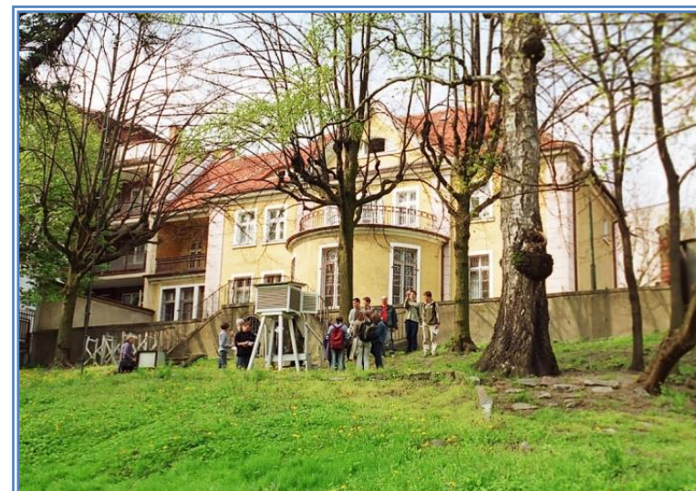
Budynek przy ul. Danielewskiego 6
